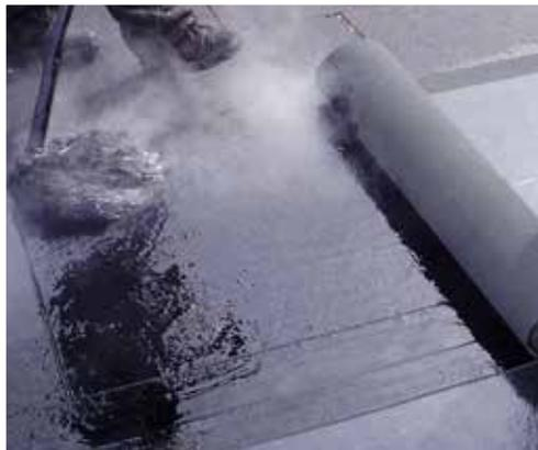
Lorsqu'elle est utilisée comme membrane de finition, la Membrane de finition **Prevent MP-HD-Cap** en adhérence totale satisfait aux exigences de la norme ONGC 37.56-M ainsi qu'à celles de la norme ASTM D6162 pour les matériaux de Type I, catégorie G. Elle est également conforme à la norme CAN/ULC S107M pour les matériaux de Classe A et aux protocoles d'essais de la norme UL790.
